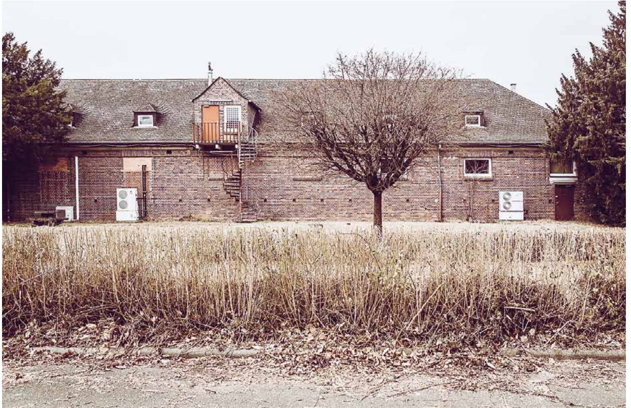
Die ehemaligen Stallungen auf den Campbell Barracks
